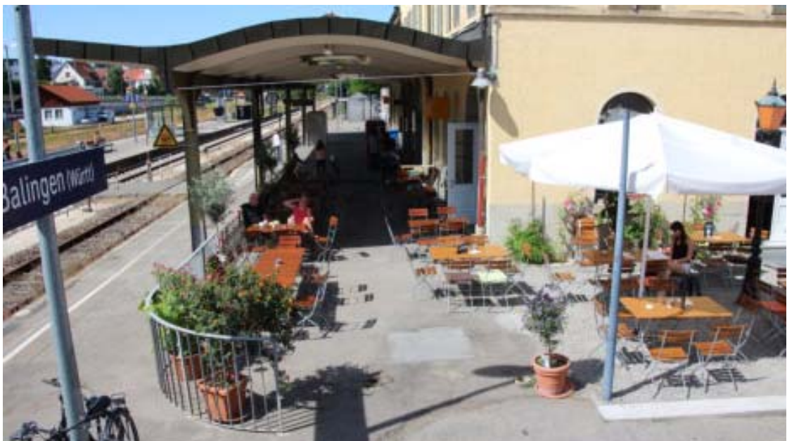
Abb. 9: Ansicht Bahnhof mit Blick zum Gleis
