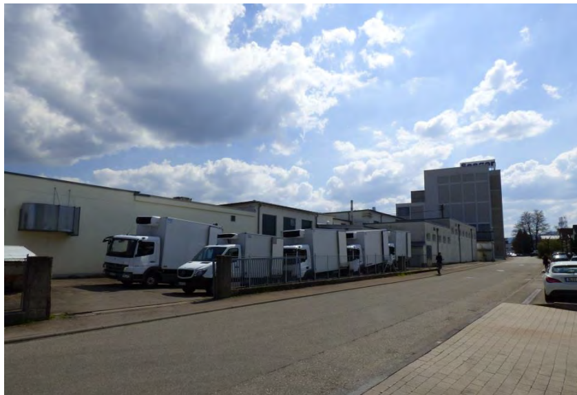
Ansicht Schlachthof, Schickhardtstraße Quelle: die STEG
